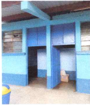
Foto 3: Mantenimiento de puertas
