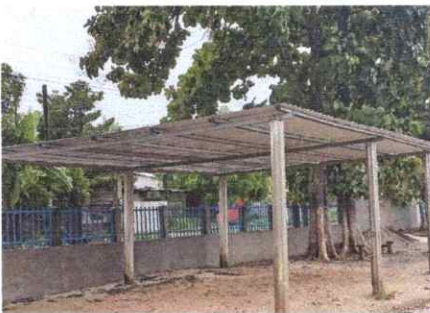
Foto 5: Sustitución de lamina troquelada
