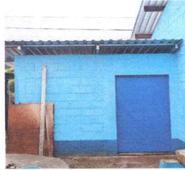
Foto 2: Sustitución de soporte de madera por metal
