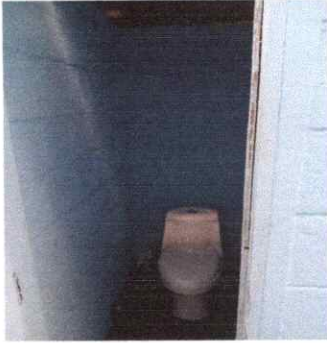
Foto1: Sustitución de inodoros
