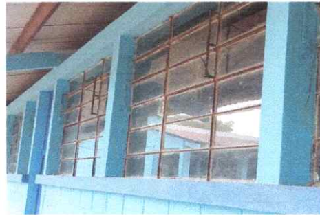
Foto 6: Sustitución de vidrios
