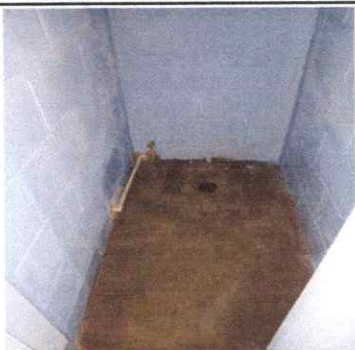
Foto 1: Sustitución de inodoros
