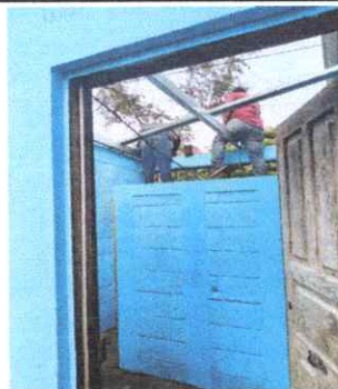
Foto 2: Sustitución de soporte de madera por metal
