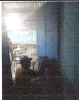
Foto 3: Mantenimiento de puertas
