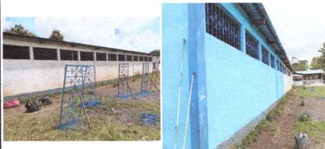
Foto 4: Mantenimiento de balcones y pintura en muros exteriores
