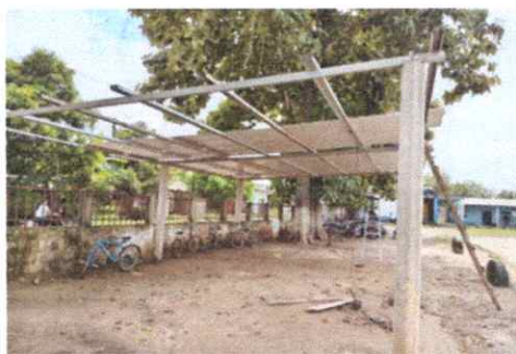
Foto 5: Sustitución de lamina troquelada
