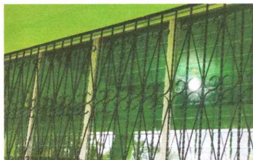
Foto 4: Instalación de los vidrios (paletas de persianas).
