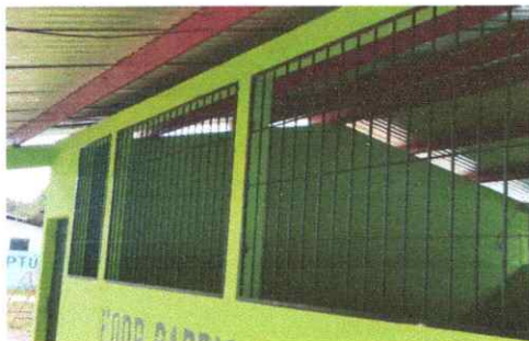
Foto 3: Finalización de colocación de estructura de metal en ventanas (balcones).
