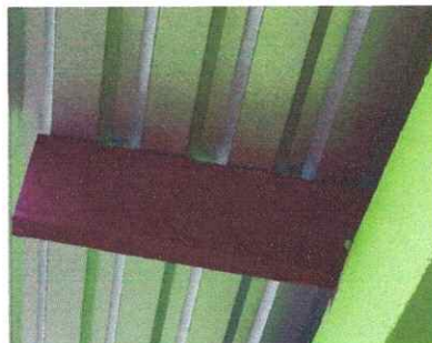
Foto 2: Finalización del mantenimiento a la estructura de soporte de metal.
