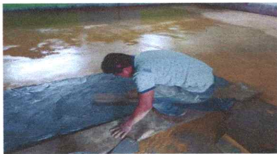
Foto 5: Pasteando piso de cemento liquido.
