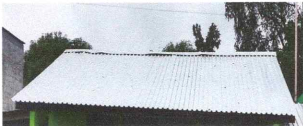
Foto1: Finalización del cambio de lámina troquelada aluzinc calibre 26.
