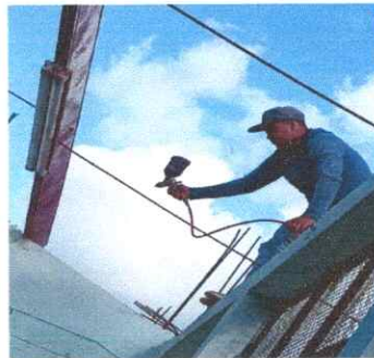
Foto 2: Mantenimiento a estructura.
