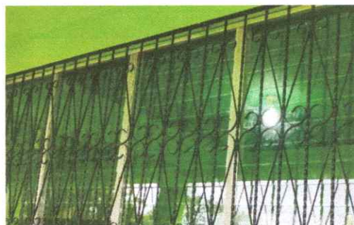
Foto 4: Instalación de los vidrios (paletas de persianas).
