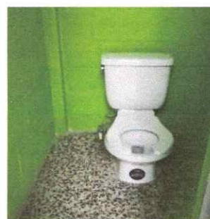
Foto 6: Colocación de los tres inodoros y puertas en sanitarios.
