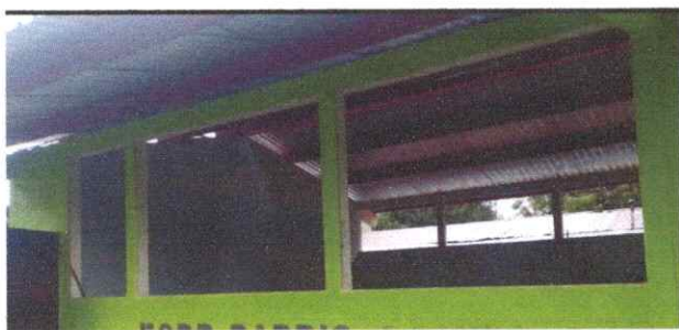
Foto 3: En espera de estructura metálica para las ventanas.
