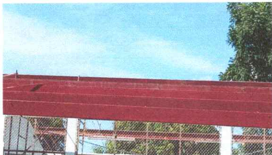
Foto1: Colocación de estructura metálica para ensamblar lámina troquelada de aluzinc calibre 26.
