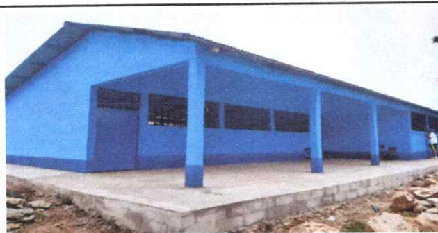
Foto 5: SUSTITUCIÓN DE PISO DE TROTA DE CONCRETO
