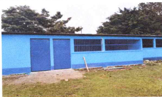
Foto 3: SUSTITUCION DE PUERTAS
