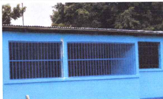
Foto 4: SUSTITUCIÓN DE ESTRUCTURA DE METAL EN VENTANA
