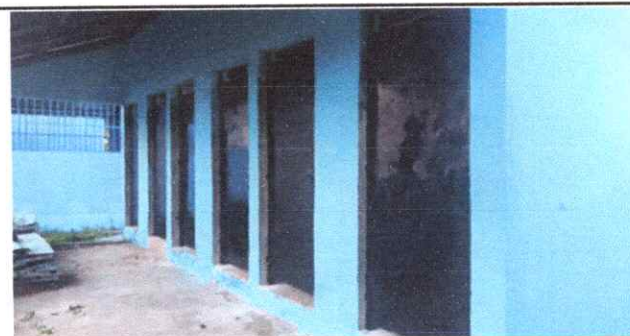
Foto 6: SUSTITUCIÓN DE PUERTAS DE SERVICIO SANITARIO
