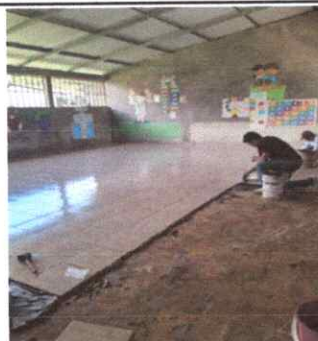
Foto 2: SUSTITUCIÓN DE PISO CERÁMICO
