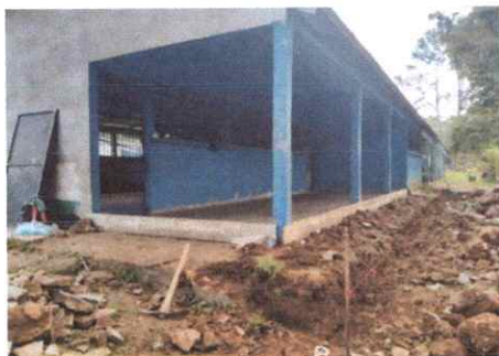
Foto 5: SUSTITUCION DE PISO DE TORTA DE CONCRETO
