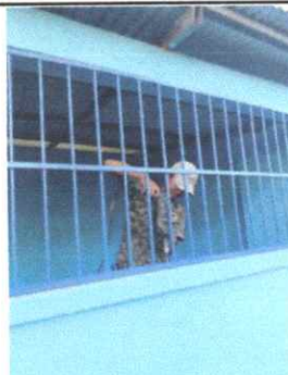
Foto 4: SUSTITUCIÓN DE ESTRUCTURA DE METAL EN VENTANA
