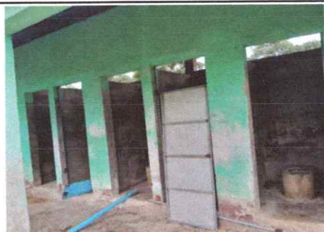
Foto 6: SUSTITUCIÓN DE PUERTAS EN SERVICIOS SANITARIO
