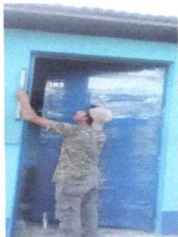
Foto 3: SUSTITUCION DE PUERTAS
