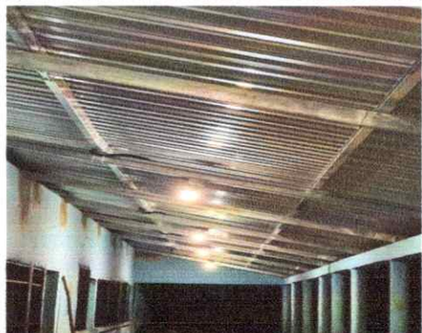
Foto 3: INSTALACION DE LAMINA TROQUELADA
