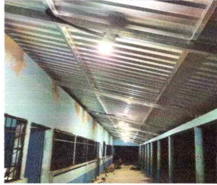
Foto 4: INSTALACION DE LA ESTRUCTURA DE METAL EN EL CORREDOR
