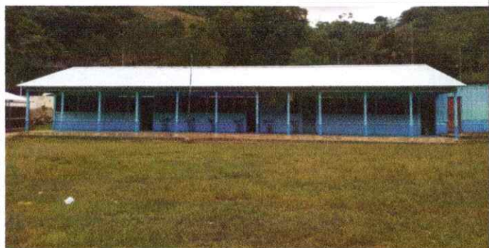
Foto1: SUSTITUCION DE LAMINA TROQUELADA
