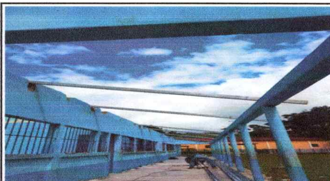
Foto 4: INSTALACION DE LA ESTRUCTURA DE METAL EN EL CORREDOR
