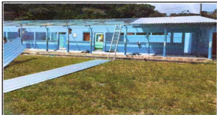
Foto 3: INSTALACION DE LAMINA TROQUELADA
