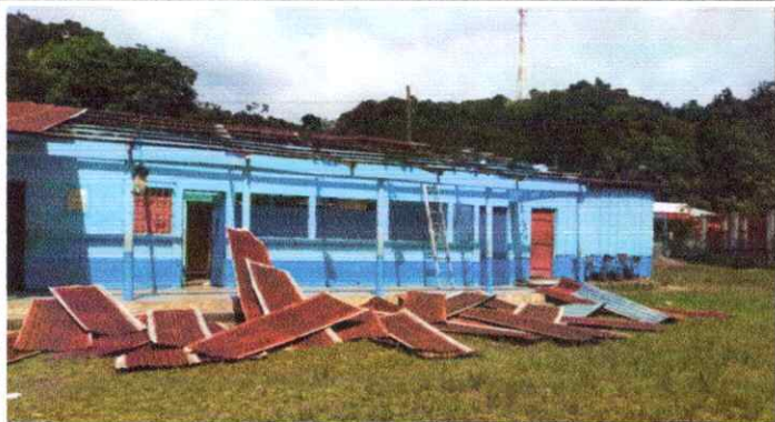
Foto1: DESMONTAJE DEL TECHO DE LAMINA
