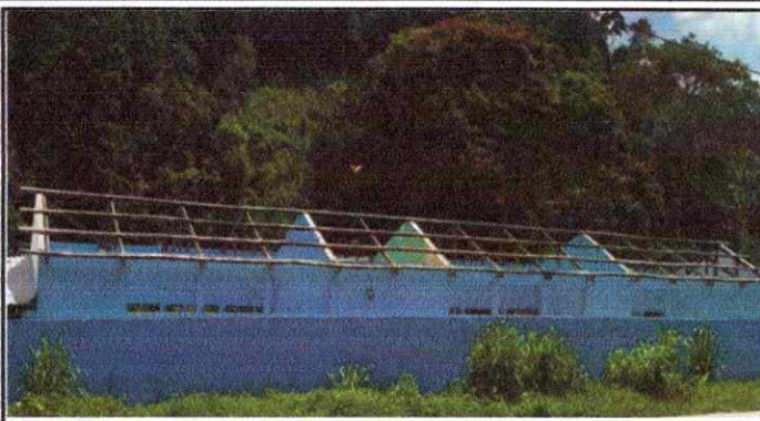
DESMONTAJE DE LA ESTRUCTURA DE MADERA
