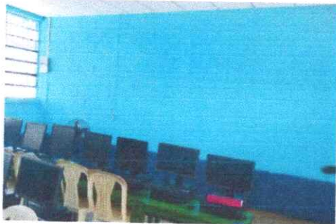
Foto1: Pintura en muros exteriores e interiores
