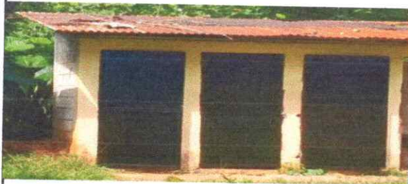
Foto 3: Sustitucion de puertas en servicio sanitarios
