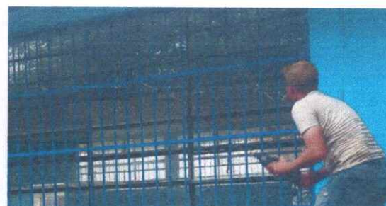
Foto 4: Sustitución de ventana de madera por metal mas vidrio
