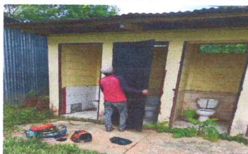
Foto 3: Sustitución de puertas en servicio sanitarios
