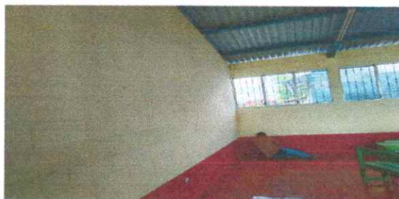
Foto1: Pintura en muros exteriores e interiores
