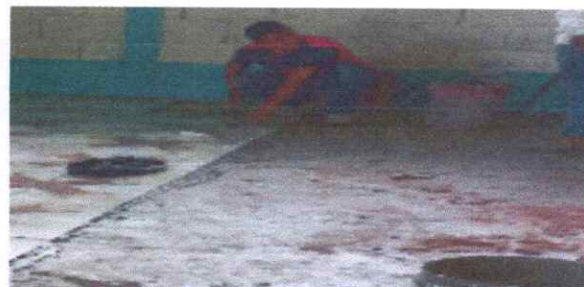
Foto 2: Sustitución de piso de torta de concreto por piso cerámico
