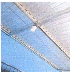
Foto 5: Cambio de focos ahorradores
