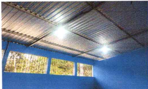
Foto1: Cambio de techo
