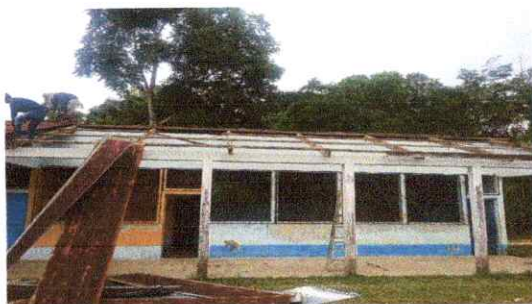
Foto1: Cambio de techo
