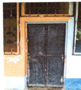
Foto 2: Mantenimiento a estructura (ljado, cambio de tubo, cepillado, sujecciones y aplicación de pintura)
