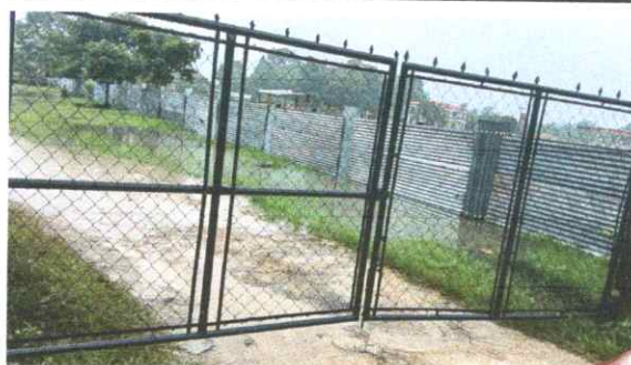
Foto 6: Mantenimiento a portón de metal.
