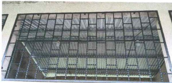
Foto1: Mantenimiento a balcones de metal.
