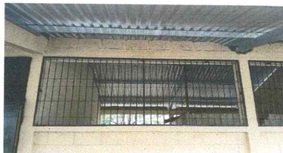
Foto 2: Sustitución de estructura de soporte de metal y elementos de fijación.
