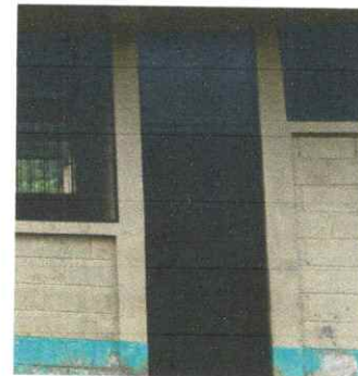
Foto 4: Sustitución de chapa.
