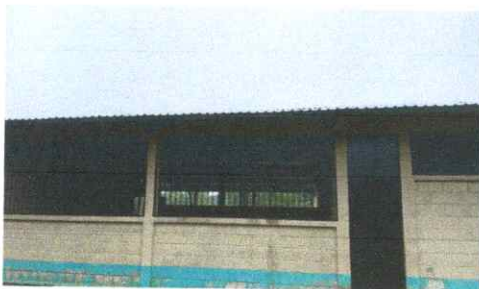
Foto 5: Sustitución de lámina troquelada alucinz calibre 26.
