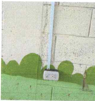
Foto 3: Sustitución de tomacorrientes dobles.
