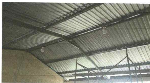
Foto 4: Instalación de focos ahorradores.
