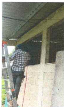
Foto1: Mantenimiento a balcones de metal.
