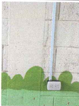
Foto 3: Instalación de tomacorrientes dobles.
