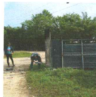
Foto 6: Mantenimiento a portón de metal.
