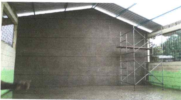
Foto 5: Sustitución de lámina por lámina troquera alucinz calibre 26.
