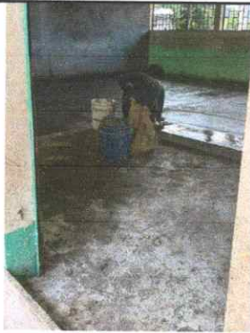
Foto1: Reparación de piso de torta de concreto.
