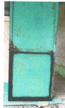
Foto 4: Sustitución de chapa.
