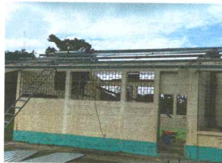
Foto 2: Sustitución de estructura de soporte de metal.
