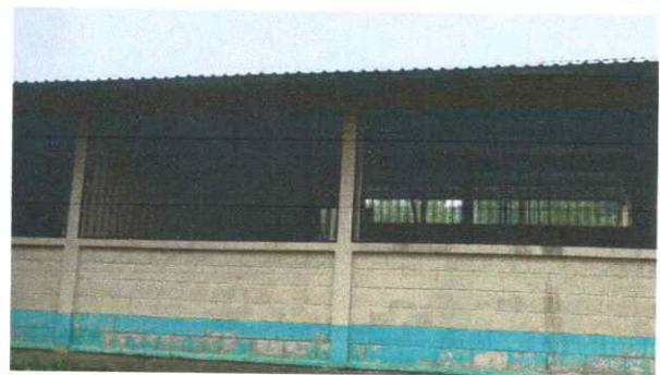
Foto 6: Fabricación e instalación de balcones de metal.
