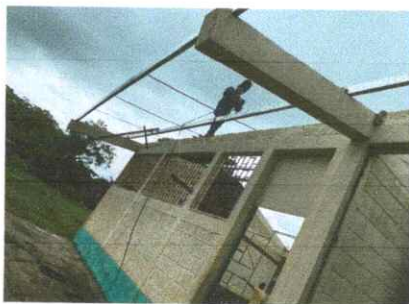
Foto 5: Reparación de cableado eléctrico.
