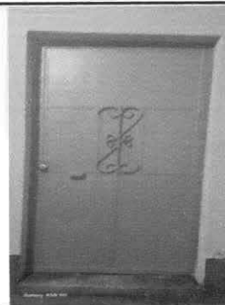
Foto 6: Sustrución de puerta de madera por metal
