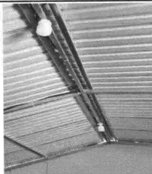
Foto 2: Sustrución de estructura de soporte de madera por metal.
