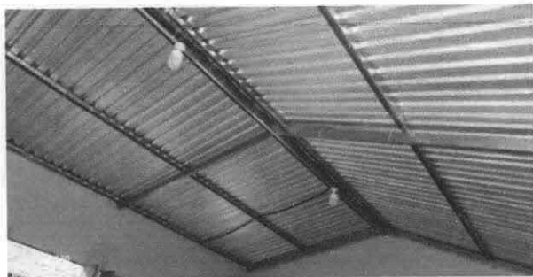
Foto 1: Sustrución de lamina por lamina troquelada
