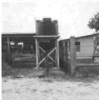
Foto 3: Sustitución de deposito de agua
