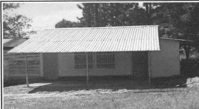
Foto 2: Instalación de lámina troquelada de corredor
