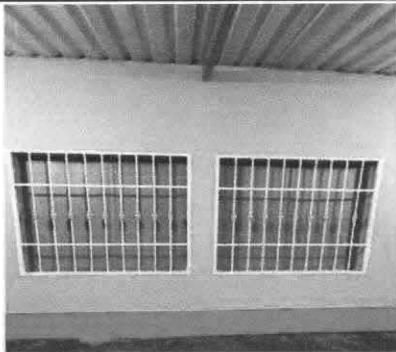
Foto1: Instalación de balcón de ventanas
