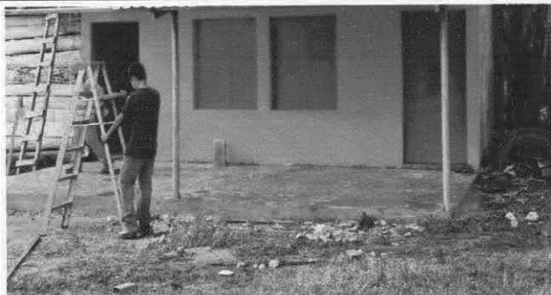
Foto1: Reparación de plancha de concreto de patio
