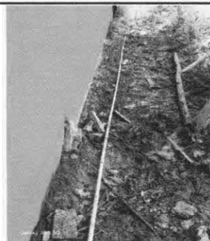
Foto 4: Sustitución de bajada de agua de rotplas de tubo PVC
