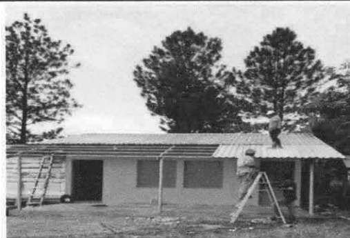
Foto 2: Instalación lámina troquelada de corredor
