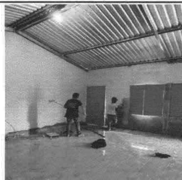
Foto 4: Pintura en muros exteriores e interiores
