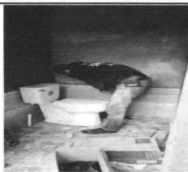
Foto 6: Sustitución de inodoro y lavamanos.
