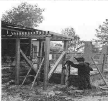
Foto 3: Sustitución de depósito de agua
