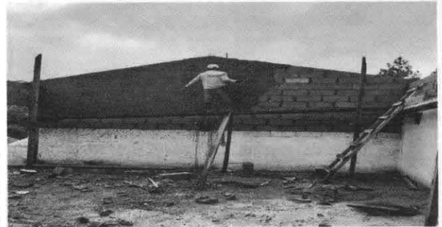
Foto 4: Levantamiento de muro perimetral
