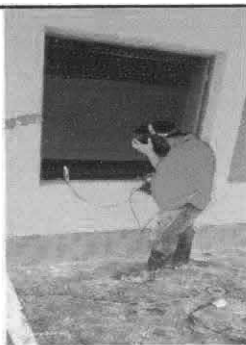
Foto 5: Sustitución de ventana de madera por metal
