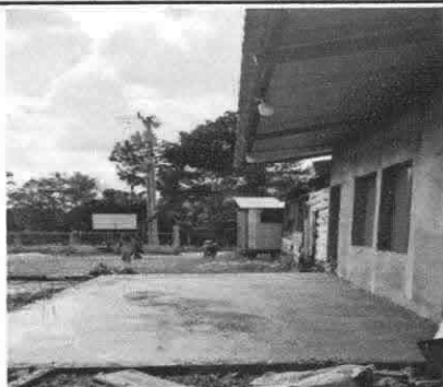
Foto 1: Reparación de plancha de concreto de patio.
