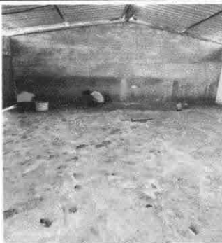
Foto 3: Sustitución de piso de torta de concreto
