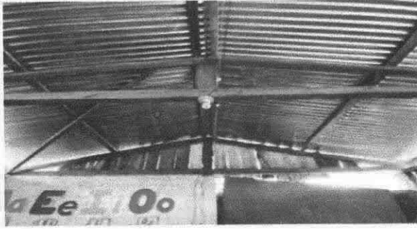
Foto1: Sustitución de lamina por lamina troquelada
