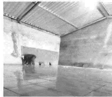
Foto 4: Pintura en muros exteriores e interiores
