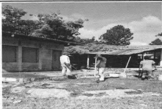
Foto1: Reparación de plancha de concreto de patio.
