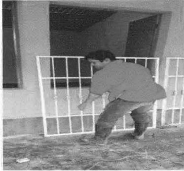
Foto1: Instalación de balcón de ventanas
