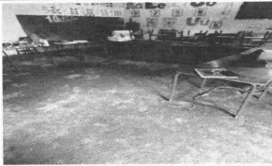
Foto 3: Sustitución de piso de torta de concreto
