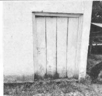
Foto 6: Sustitución de puerta de madera por metal
