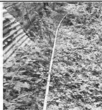
Foto 4: Sustitución de bajada de agua de rotoplas de tubo PVC.
