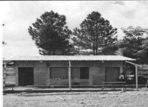
Foto 2: Instalación de lámina troquelada de corredor
