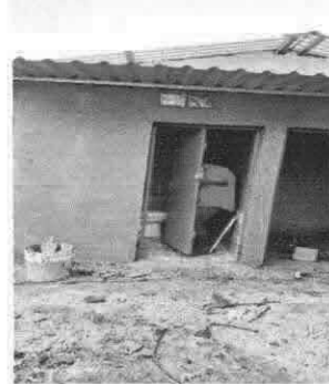
Foto 2: Instalación de puertas de metal en baños y bodegas
