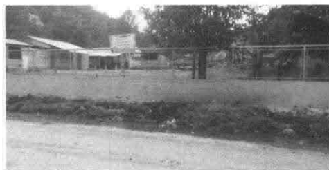
Foto 3: Parte frontal de muro lado izquierdo
