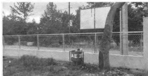
Foto 4: Parte d adentro del muro terminado.
