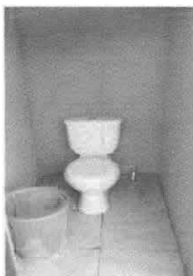
Foto1: Instalación de primer baño
