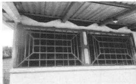
Foto1: Pintura colocada en los 2 orimeros balcones.
