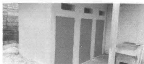
Foto 6: colocación de pintura.
