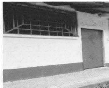
Foto 2: Pintura colocada en primera puerta.
