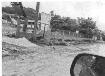
Foto1: Terminación de muro.
