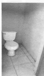
Instalación del tercer baño.
