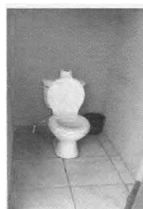
Foto 2: Instalación de segundo baño.
