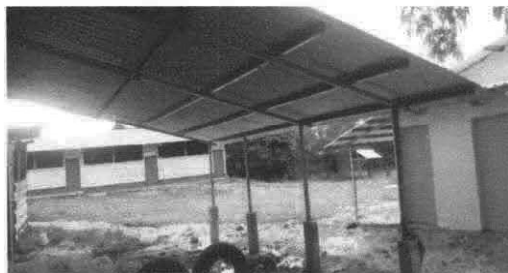
Foto 2: fundiciones de concreto para más durabilidad.
