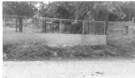
Foto 2: Parte frontal de muro lado derecho.
