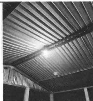
Instalación de cableado y luz en comedor.
