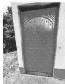
Foto 4: puerta terminas de ultima aula.
