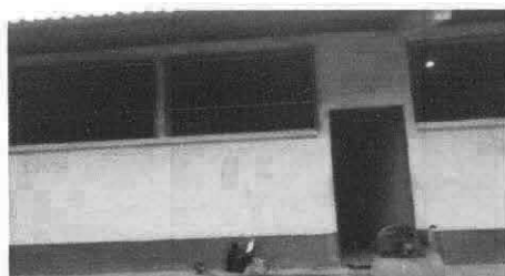
Foto 5: Segunda puerta y balcones terminados.
