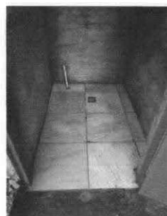
Foto 6: Instalación de piso cerámico.
