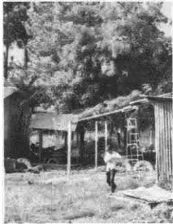
Foto1: Desarmado de galera.
