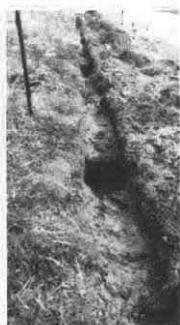
Foto 3: Zanjeo par realización del muro.
