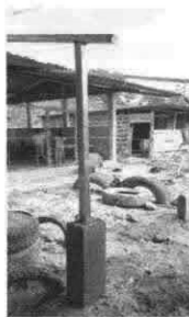
Foto 5: Instalando costaneras de metal.
