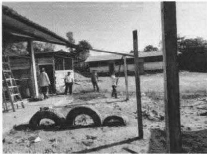
Foto 3: Sacando poste de la galera.
