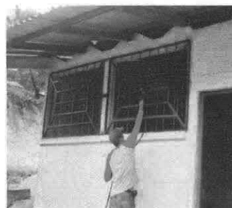
Foto 6: Pintura de los ultimos balcones.
