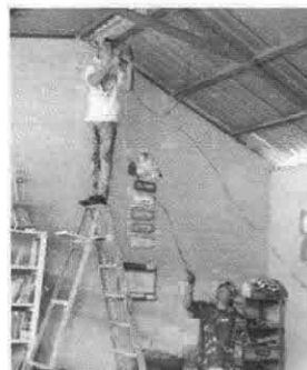
Foto 4: Instalación de cableado en aulas.
