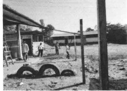
Foto 2: Quitando vigas de la galera.
