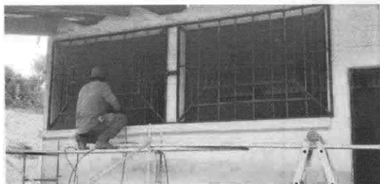
Foto1: Raspado de balcones.
