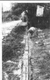
Foto 5: Levantado de muro con block.
