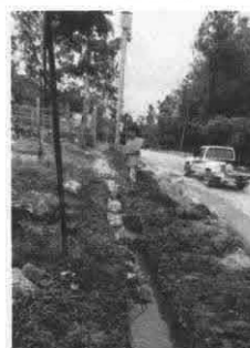
Foto 4: Colocación de piedras para fundición.
