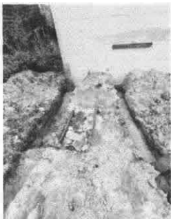
Foto 1: Zanjeo para realización de los baños
