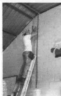
Foto 6: Instalación de tomacorrientes.
