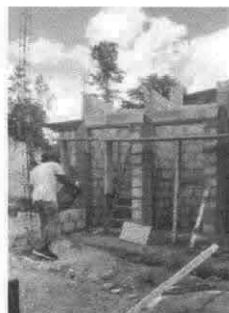
Foto 4: Fundición para que hagan forma las divisiones.
