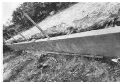
Foto 6: Colocación de mtuberia para malla.
