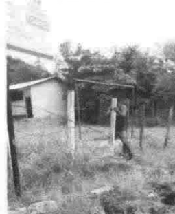
Foto 2: Retiro de postes de cerco.
