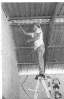
Foto 3: Instalación de acometida eléctrico.
