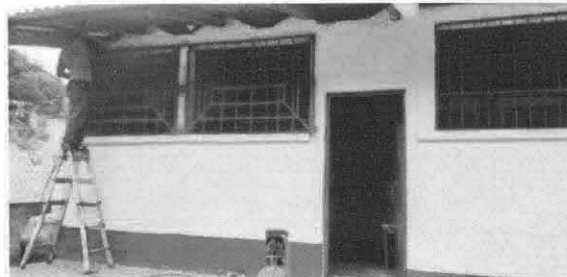
Foto 2: Pintado de balcones.
