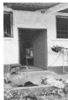
Foto 4: Primera puerta terminada.
