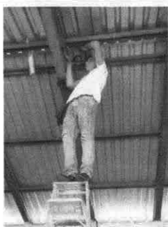
Foto 5: Instalación de bombillos ahorradores
