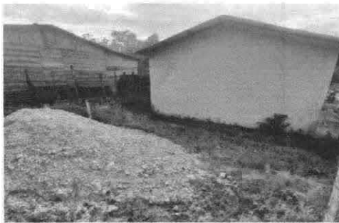
Foto 5: Espacio adecuado para los baños.
