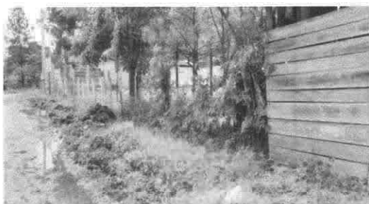
Foto 3: Reparación de malla
