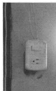
Foto 6: Cambio de cableado de tomacorrientes.
