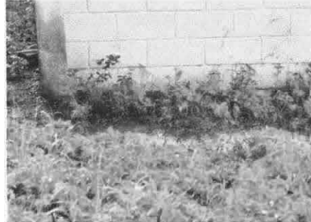
Foto 2: lugar donde se hará el zanjeo.
