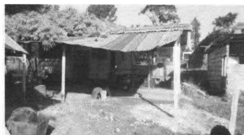
Foto 4: vista de galera con laminas viejas.
