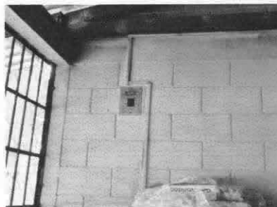
Foto2: Cambio de tablero de flipon.
