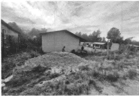
Foto 3: Espacio donde se realizará los baños.
