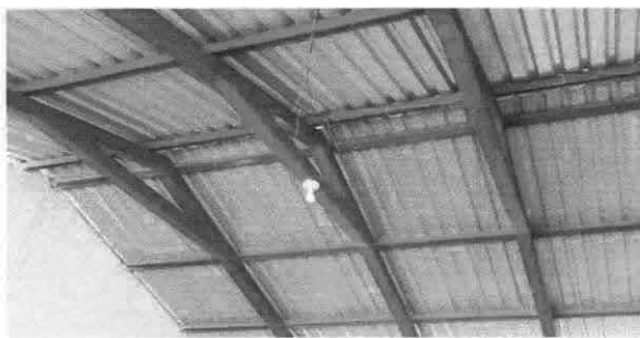
Foto 5: Cambio de focos ahorradores
