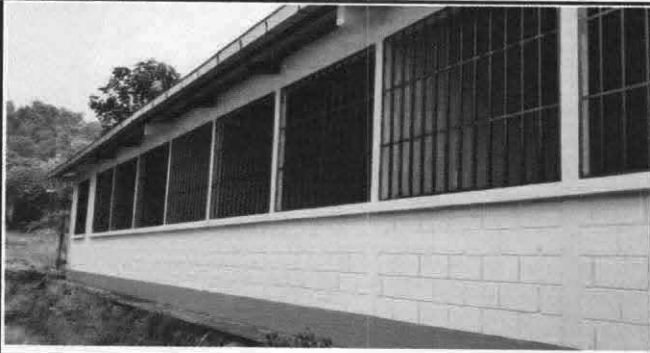
Foto1: Mantenimiento de Balones de metal
