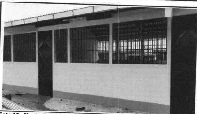
Foto 15: Mantenimiento de estructura (lijado, cepillado y pintado)
