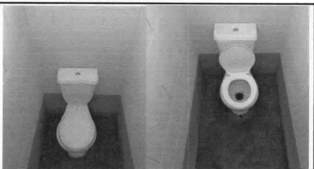
Foto 11: Instalación de inodoro
