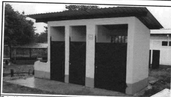
Foto 16: Mantenimiento de estructura (lijado, cepillado y pintado)
