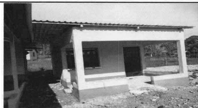
Foto 9: Instalación de lámina troquelada aluzinc calibre 26
