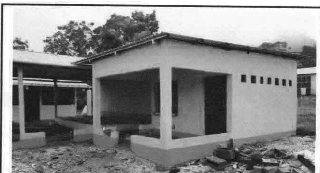
Foto 4: Pintura de muros exteriores e interiores
