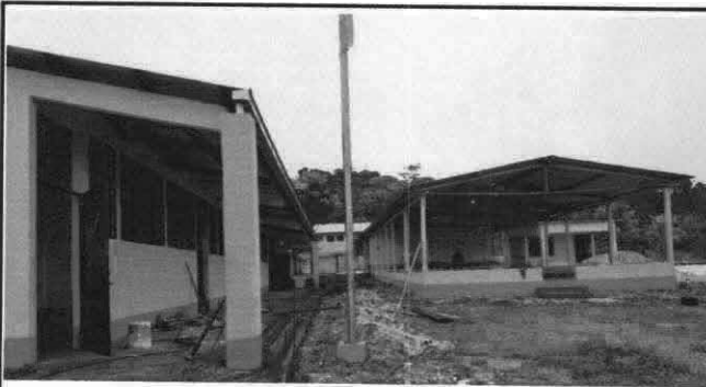
Foto 3: Pintura de muros exteriores e interiores
