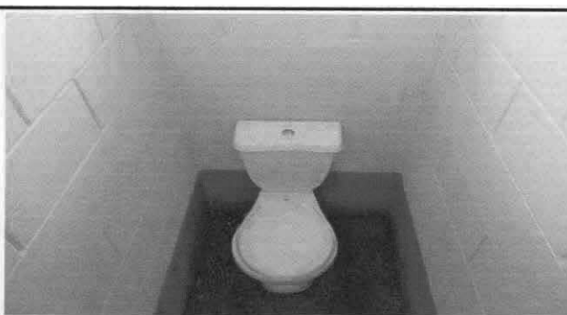
Foto 12: Instalación de inodoro
