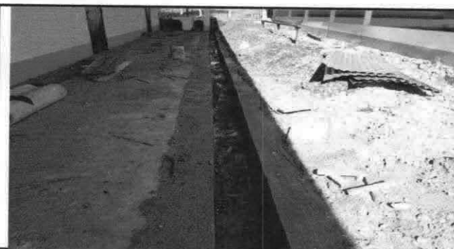
Foto 5: Instalación de tubería principal de PVC
