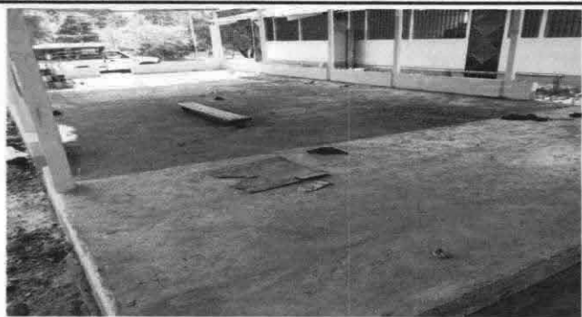
Foto 7: Sustitución de piso de torta de concreto
