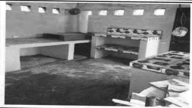
Foto 14: Mantenimiento de estufa rural
