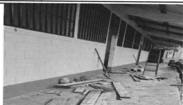
Foto2: Mantenimiento de Balones de metal
