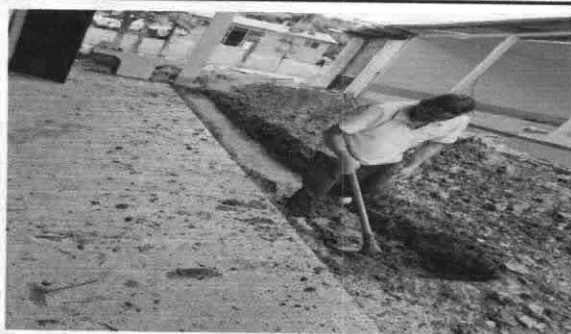
Foto 5: Instalación de tubería principal de PVC
