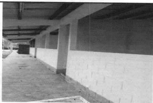
Foto 3: Pintura de muros exteriores e interiores
