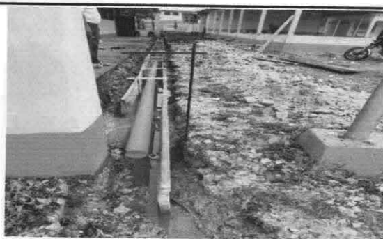
Foto 6: Instalación de tubería principal de PVC
