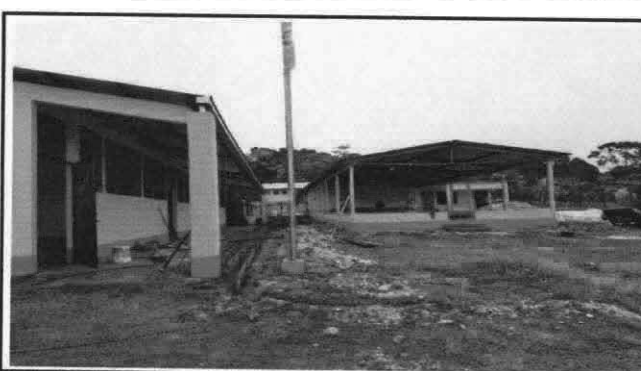
Foto 4: Pintura de muros exteriores e interiores
