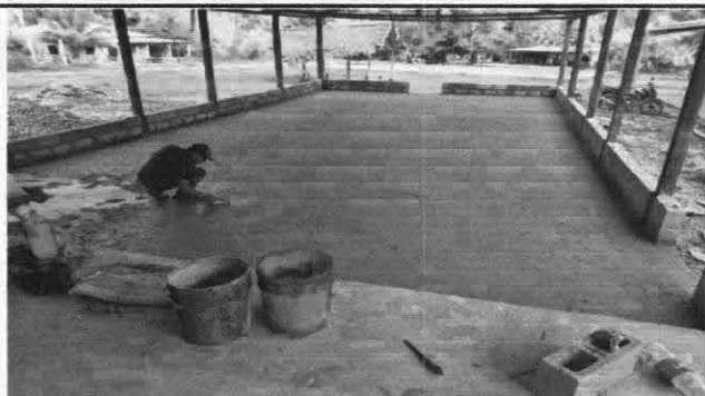
Foto 7: Sustitución de piso de torta de concreto
