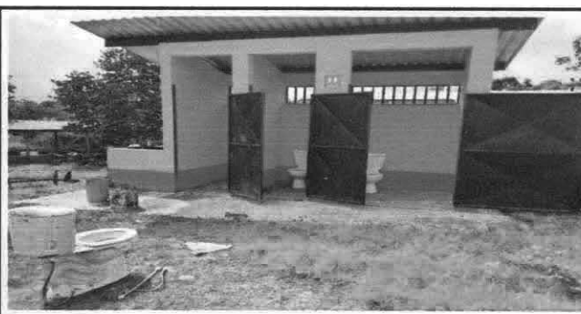
Foto 12: Instalación de inodoro
