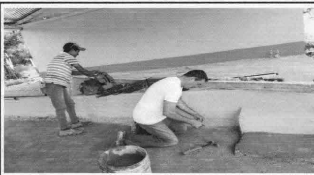
Foto 8: Sustitución de piso de piso de torta de concreto
