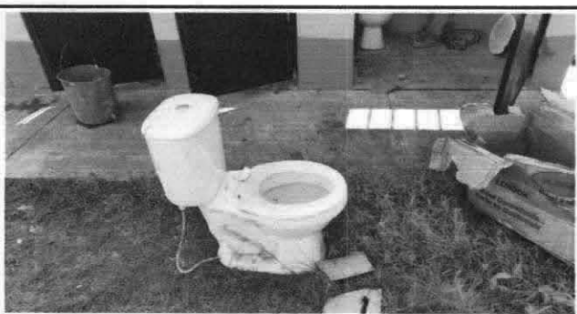
Foto 11: Instalación de inodoro
