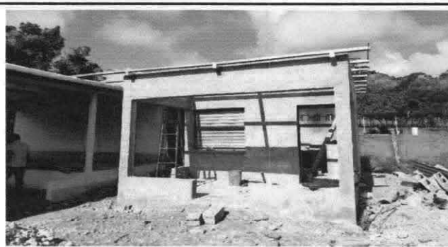
Foto 9: Instalación de lámina troquelada aluzinc calibre 26
