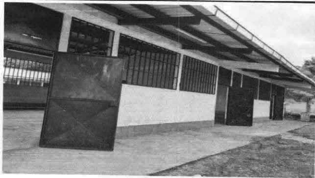
Foto 15: Mantenimiento de estructura (lijado, cepillado y pintado)
