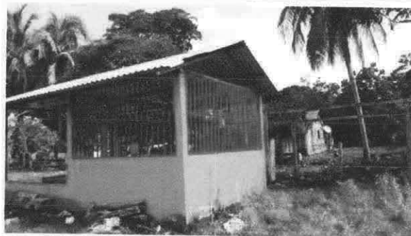
Foto 6: FABRICACIÓN E INSTALACIÓN DE BALCONES DE HIERRO
