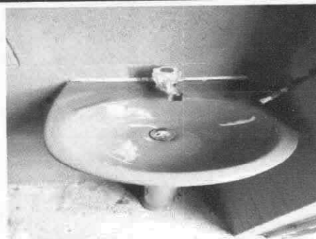
Foto 8: SUSTITUCIÓN DE LAVAMANOS
