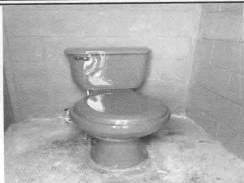
Foto 7: SUSTITUCIÓN DE INODOROS
