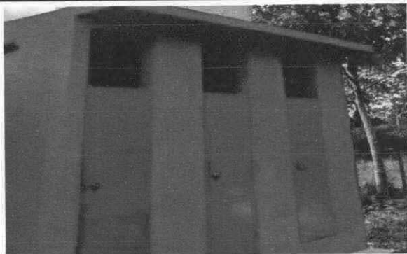
Foto 9: PINTURAS EN MUROS EXTERIOR E INTERIOR
