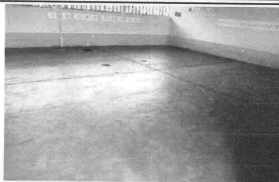
Foto 2: SUSTITUCIÓN DE PISO DE CEMENTO LÍQUIDO
