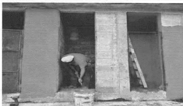
Foto 9: PINTURAS EN MUROS EXTERIOR E INTERIOR
