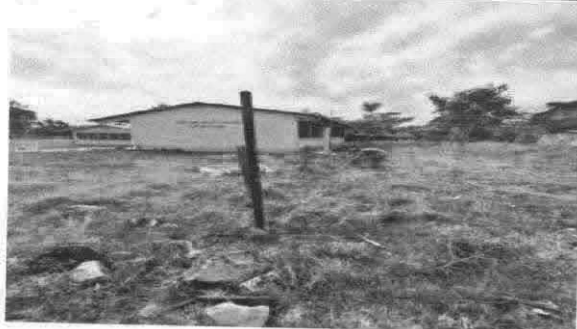
Foto 5: REPARACIÓN DE CERCA DE ALAMBRE DE PUA
