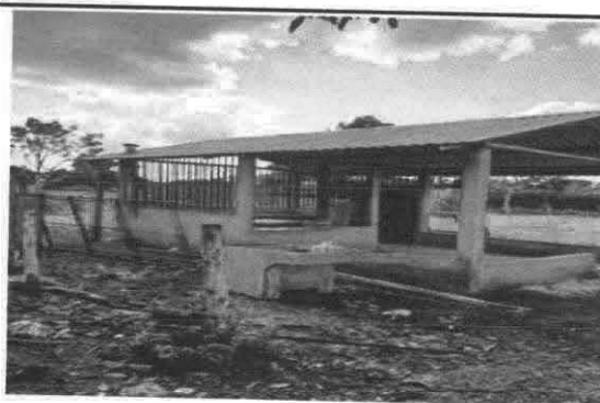
Foto 4: SUSTITUCIÓN DE PILA DE CEMENTO DE DOS LAVADERAS
