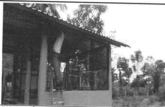
Foto 6: FABRICACIÓN E INSTALACIÓN DE BALCONES DE HIERRO EN VENTANAS
