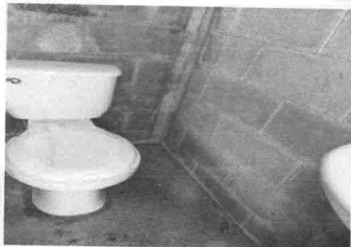
Foto 7: SUSTITUCIÓN DE INODOROS
