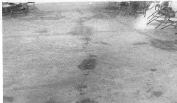
Foto 2: SUSTITUCIÓN DE PISO DE CEMENTO LÍQUIDO
