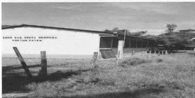
Foto 5: REPARACIÓN DE CERCA DE ALAMBRE DE PUA
