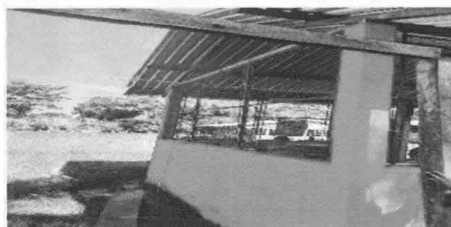
Foto 6: FABRICACIÓN E INSTALACIÓN DE BALCONES DE HIERRO EN VENTANAS
