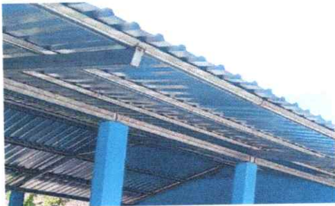
Foto 4: Sustitución de lámina, por lámina troquelada aluzinc calibre26
