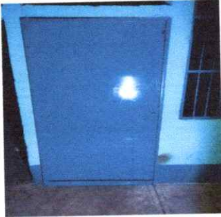
Foto 2: Sustitución de puertas
