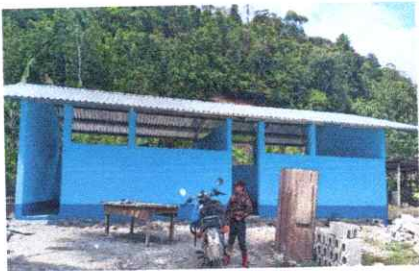
Foto1: Pintura en muros exteriores e interiores
