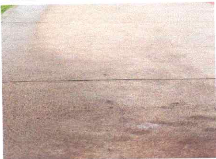
Foto 5:Reparación de piso de torta de concreto
