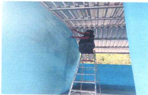
Foto 4: Sustitución de lámina, por lámina troquelada aluzinc calibre26
