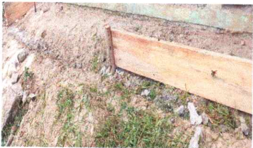
Foto 5:Reparación de piso de torta de concreto
