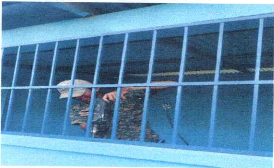
Foto 3:Sustitución de balcones de metal
