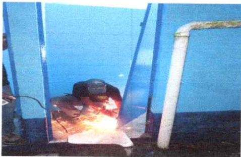
Foto 2: Sustitución de puertas
