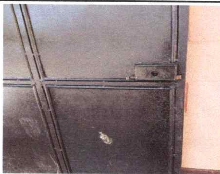
Foto 4: Mantenimiento a puerta de metal
