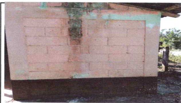
Foto 3: Pintura en muros interior y exterior
