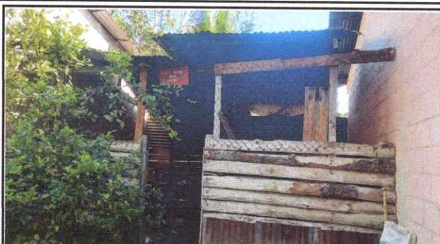
Foto 2: Estructura de techo
