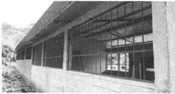
Foto 3: Sustrucción de balcones de metal
