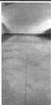
Foto 1: Sustrucción de piso de torta de concreto
