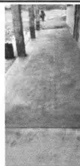
Foto 2: Sustrucción de piso de torta de concreto
