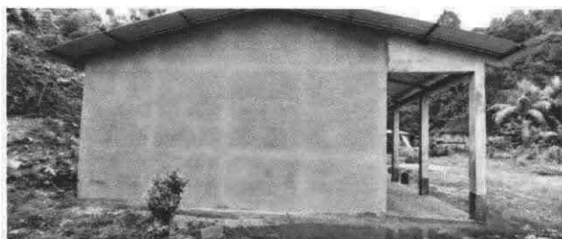
Foto 3: Repello en muro
