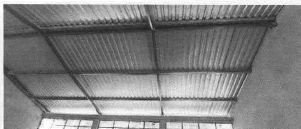
Foto 4: Instalación de lámina troquelada
