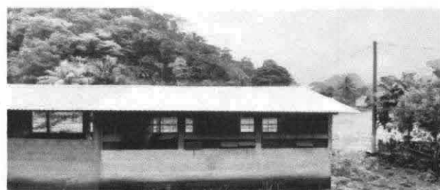
Foto 5: Instalación de lámina troquelada
