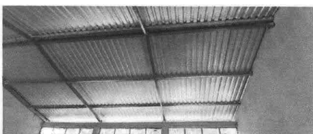
Foto 4: Instalación de estructura portante de metal
