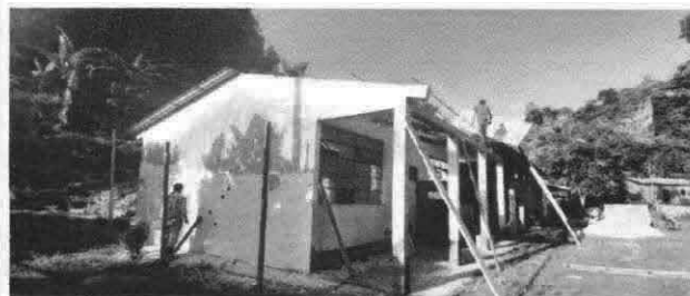
Foto 4: Repello en muro
