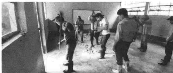
Foto1: Sustitución de piso de torta de concreto
