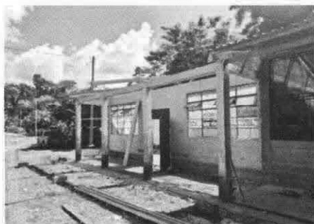
Foto 3: Instalación de estructura portante de metal
