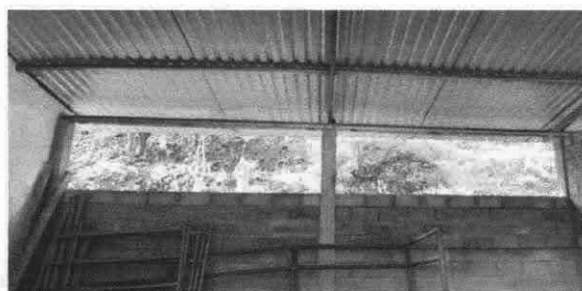
Foto 6: Sustitución de balcones de metal
