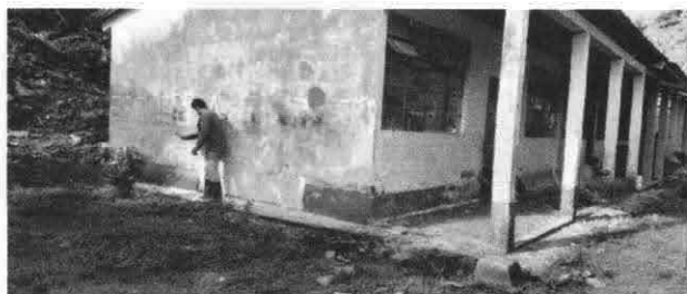
Foto 3: Repello en muro
