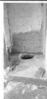
Foto 6: Sustitución de inodoro
