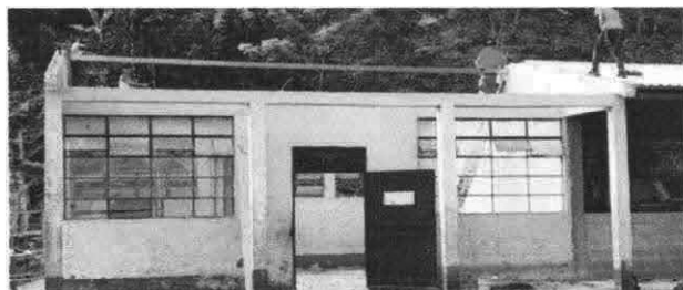
Foto 1: Instalación de lámina troquelada Aluzinc
