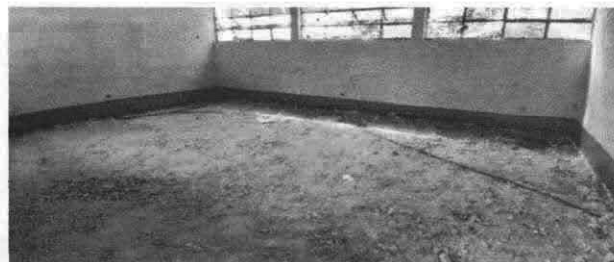
Foto 2: Sustitución de piso de torta de concreto
