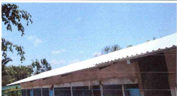
Foto1: Sustitución de lámina, por lámina troquelada
