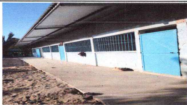
Foto1: Sustrucción de piso de torta de concreto
