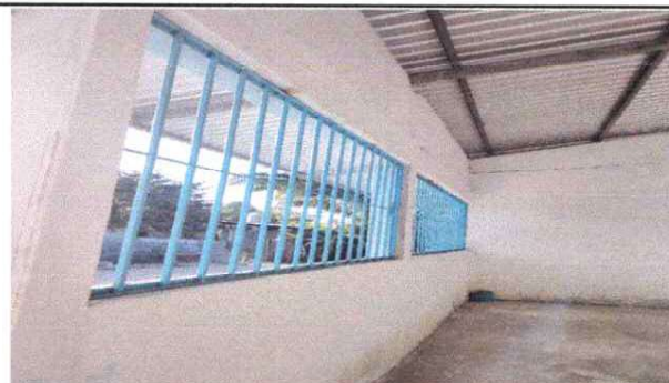
Foto 4: Mantenimiento a balcones de metal
