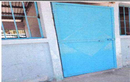
Foto 3: Mantenimiento a estructura, puertas de metal y puertas en servicios sanitarios
