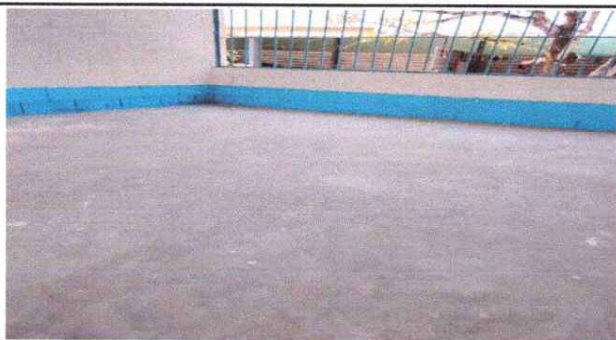
Foto 5: Sustitución de piso de cemento líquido
