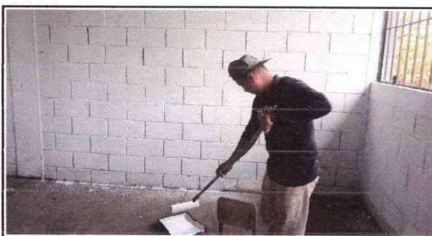
Foto 6: Pintura en muros interiores
