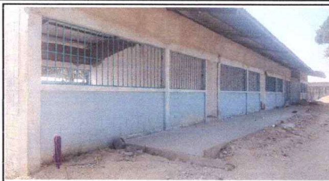
Foto1: Sustrucción de piso de torta de concreto
