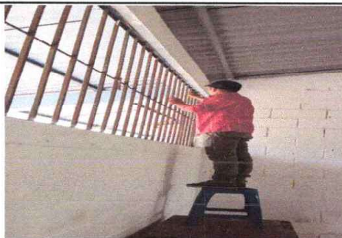
Foto 4: Mantenimiento a balcones de metal
