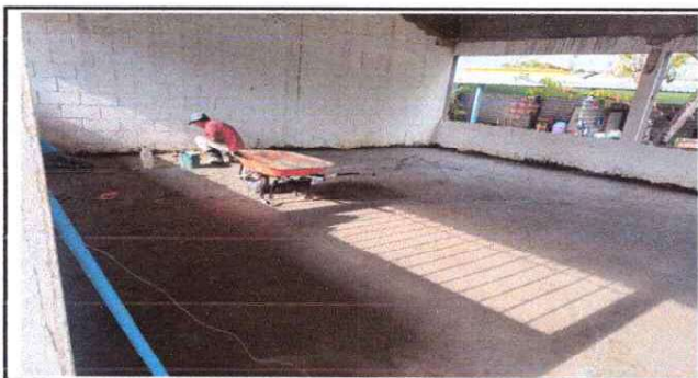
Foto 5: Sustrucción de piso de cemento liquido
