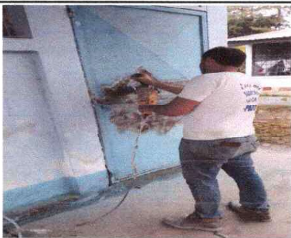
Foto 3: Mantenimiento a estructura, puertas de metal y puertas en servicios sanitarios
