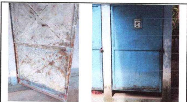
Foto 3: Mantenimiento a estructura, puertas de metal y puertas en servicios sanitarios
