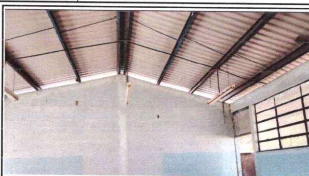
Foto 2: Sustitución de estructura de soporte de metal, por metal
