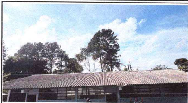
Foto1: Sustitución de lámina, por lámina troquelada
