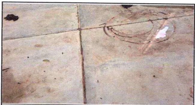
Foto 5: Sustitución de piso de cemento liquido
