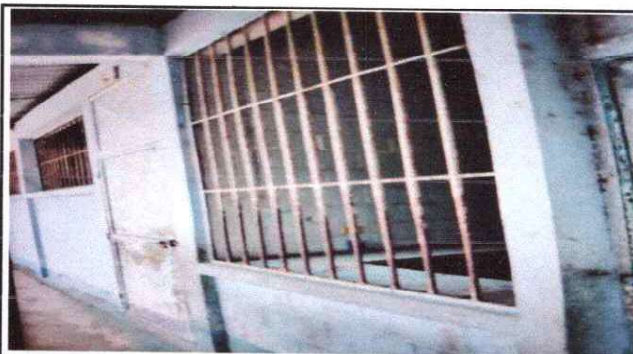
Foto 4: Mantenimiento a balcones de metal
