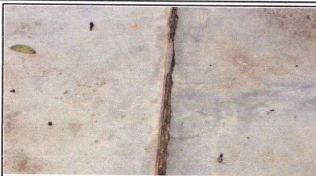
Foto1: Sustrución de piso de torta de concreto
