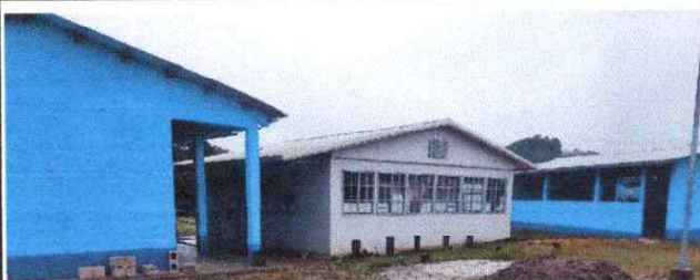
Foto1: Sustitución de canal de metal
