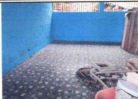
Foto1: Sustitución de piso de torta de concreto
