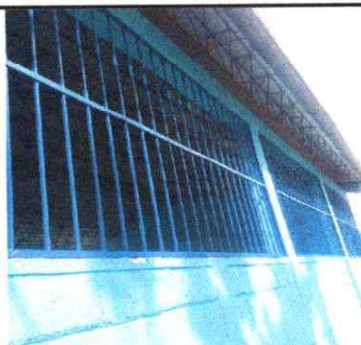
Foto 3: Sustitución de estructura de metal de ventana
