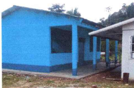
Foto 5: Pintura en muros exteriores e interiores
