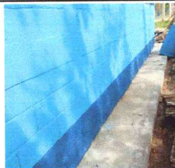
Foto 4: Reparación de cunetas
