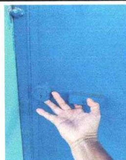
Foto 6: Sustitución de chapa
