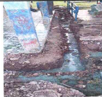
Foto 4: Reparación de cuneta
