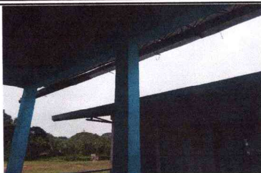
Foto1: Sustrucción de canal de metal
