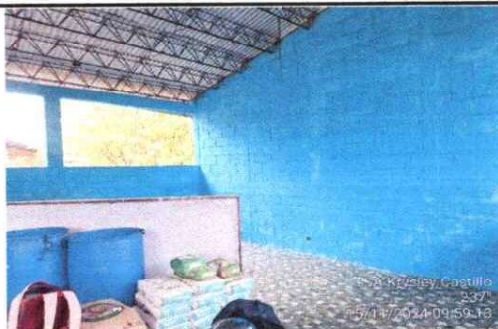
Foto 5: Pintura en muros exteriores e interiores
