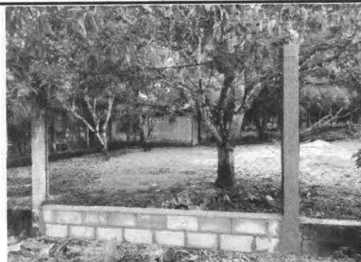
Foto 8: Reparación de muro perimetral de block
