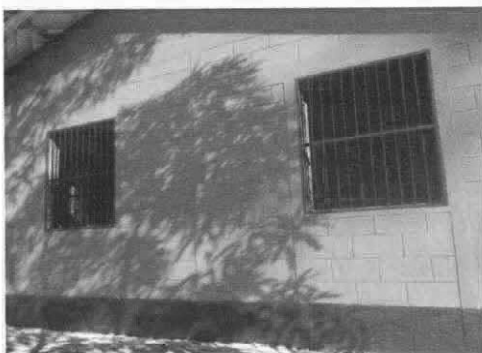
Foto 9: Fabricación e instalación de balcones de hierro
