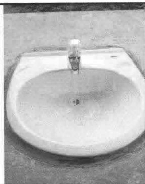
Foto 11: Sustitución de lavamanos
