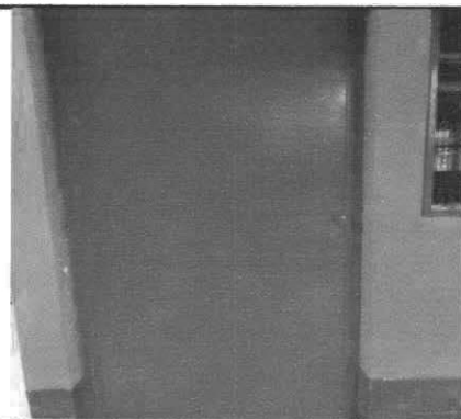
Foto 4: Sustitución de puerta
