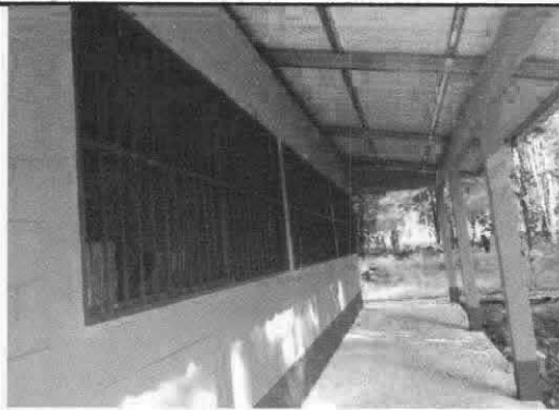
Foto 3: Sustitución de balcones de metal
