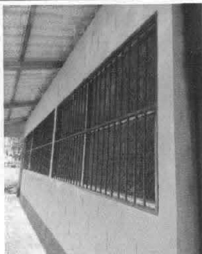
Foto 7: Pintura de muros exteriores y interiores
