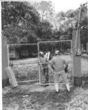
Foto1: Mantenimiento en portón de metal
