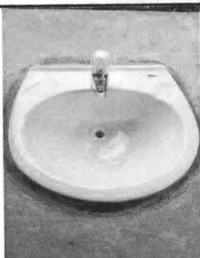
Foto 11: Sustitución de lavamanos
