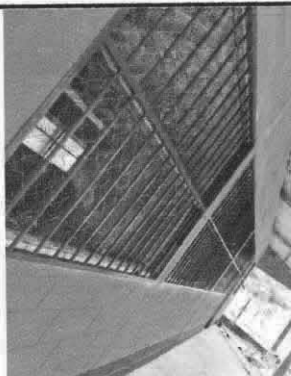
Foto 3: Sustitución de balcones de metal
