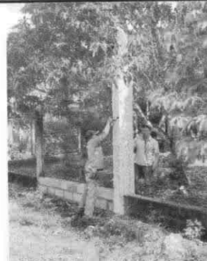
Foto 8: Reparación de muro perimetral de block
