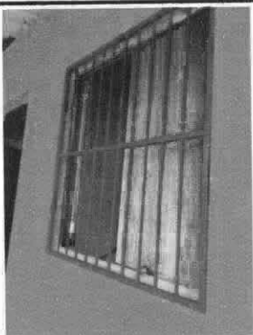
Foto 9: Fabricación e instalación de balcones de hierro
