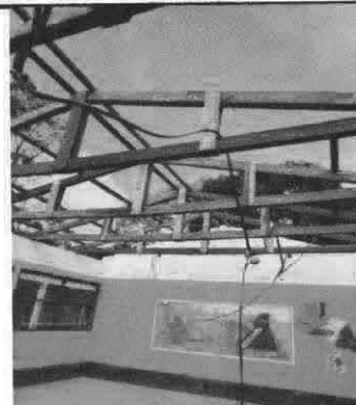
Foto 2: 1. Sustitución de estructura de soporte madera por metal, 2.Sustitución de elementos de fijación, 3.Instalación de estructura portante de metal
