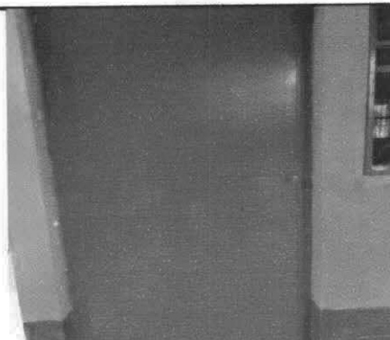
Foto 4: Sustitución de puerta
