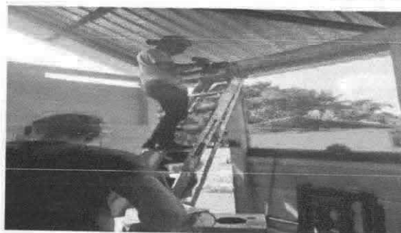
Foto 4: Sustitución de ducto eléctrico más accesorios.
