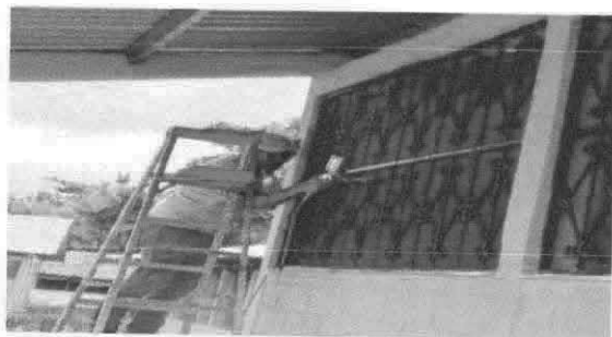
Foto 5: Mantenimiento a estructura de metal de ventana.
