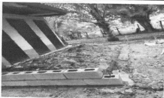
Foto 3: Reparación de banqueta de concreto.
