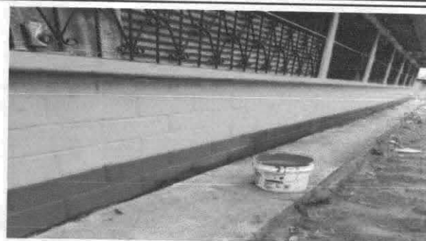
Foto 2: Pintura en muros exteriores e interiores.
