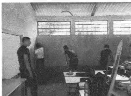
Foto 3: Pintado de muros exteriores e interiores
