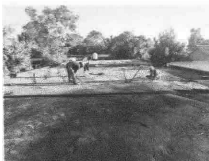
Foto 3: Limpieza de terraza para aplicar el impermeabilizante
