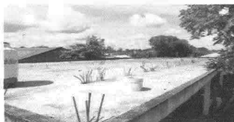
Foto 4: Limpieza de terrazas
