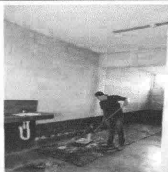
Foto 2: Pintado de muros exteriores e interiores
