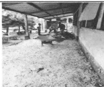
Foto 6: Sustitución de piso
