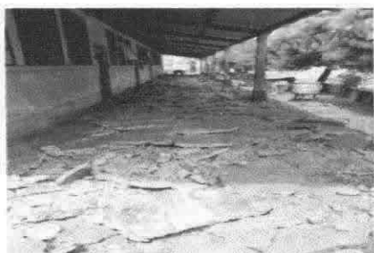
Foto 5: Sustitución de piso
