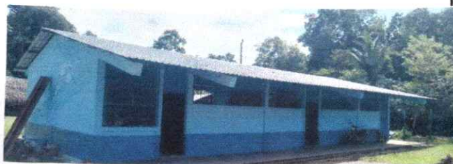
Foto 5: Pintura en muros exteriores e interiores
