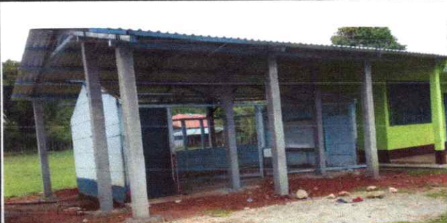
Foto 5: Instalación de lámina troquelada aluzinc
