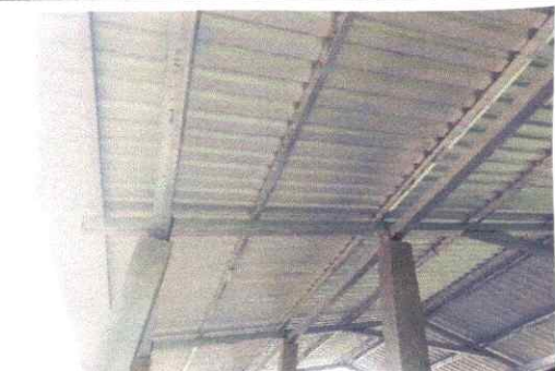
Foto 3: Sustrucción de lámina, por lámina troquelada aluzinc calibre 26
