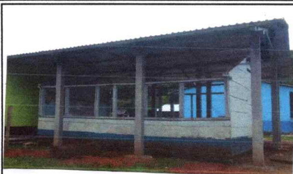
Foto1: Desinstalación de estructura portante
