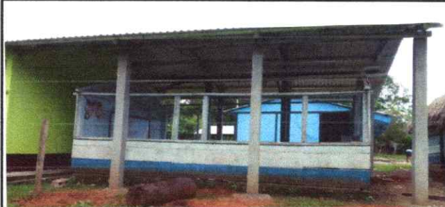
Foto 4: Sustitución de capote de lámina para lámina troquelada
