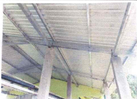
Foto 3: Sustitución de elementos de fijación
