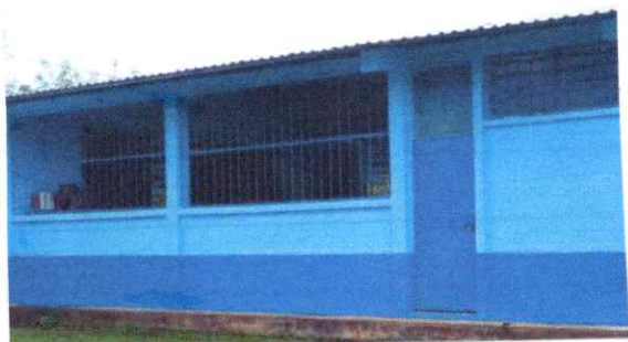
Foto 1: Sustrucción de balcones de metal
