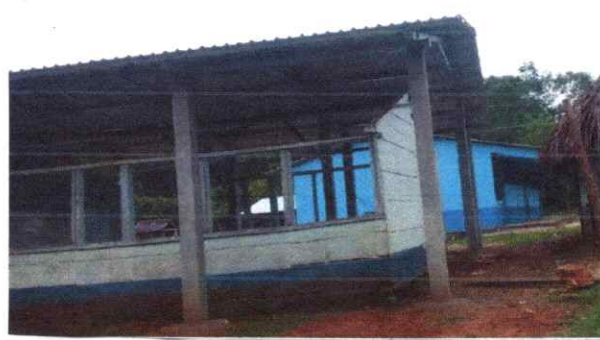
Foto 4: Desinstalación de lámina existente
