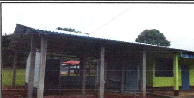
Foto 2: Instalación de estructura portante de metal
