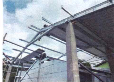
Foto 2: Instalación de estructura portante de metal
