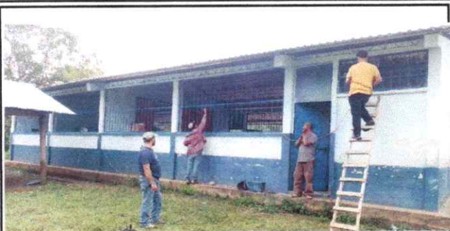
Foto 1: Sustitución de balcones de metal
