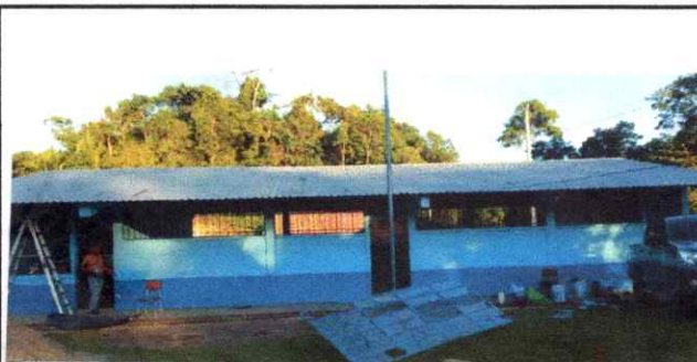
Foto 5: Pintura en muros exteriores e interiores
