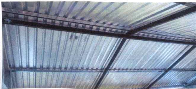
Foto 3: Sustitución de elementos de fijación
