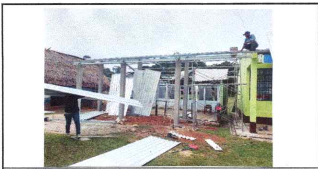
Foto 5: Instalación de lámina troquelada aluzinc
