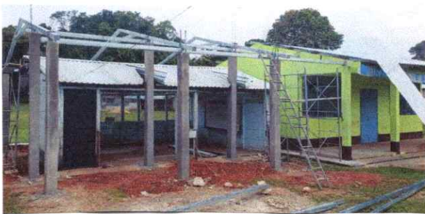
Foto 1: Desinstalación de estructura portante
