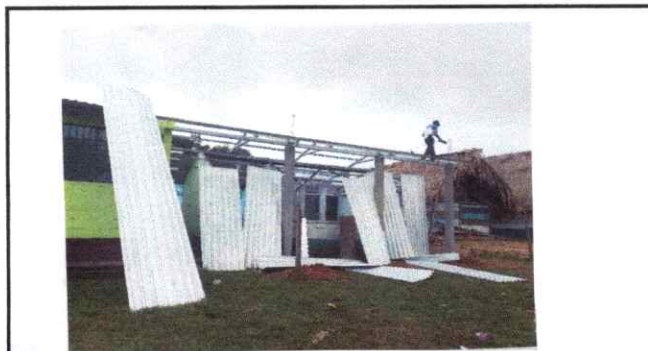
Foto 4: Desinstalación de lámina existente
