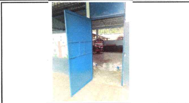
Foto 2: Sustitución de puerta
