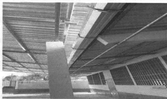
Foto 4: COLOCACIÓN DE BAJADA DE AGUA FLUVIAL
