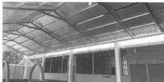
Foto 2: COLOCACION DE COLUMNAS DE CONCRETO
