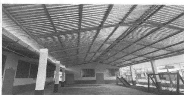
Foto 5: INSTALACIÓN DE COSTANERAS 2X3
