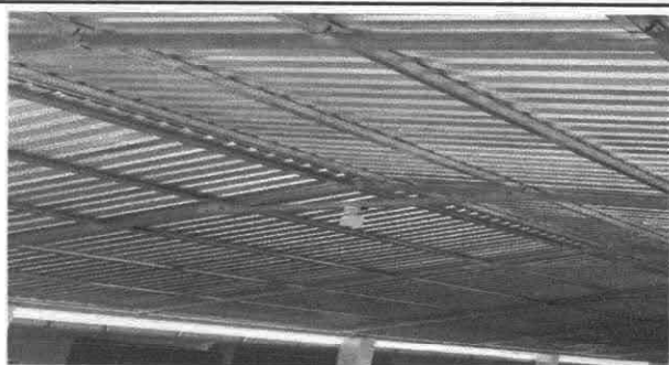
Foto 3: COLOCACIÓN DE ESTRUCTURA METÁLICA Y LÁMINA
