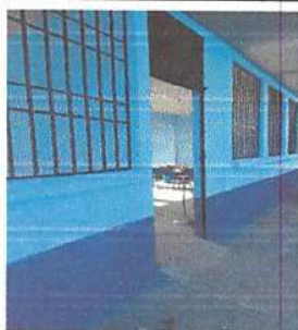
Foto 3: Pintura en muros exteriores e interiores
