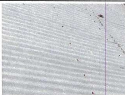
Foto 11: Desinstalación de lámina existente
