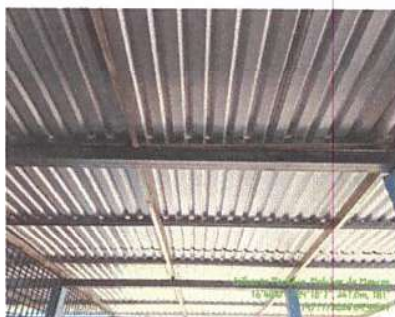
Foto 9: Instalación de lámina troquelada aluzinc
