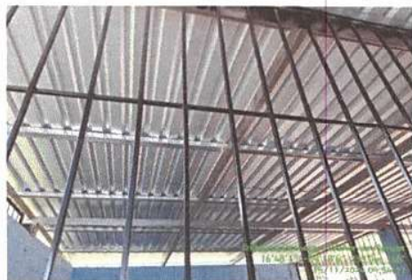
Foto 3: Sustrucción de estructura de soporte de madera, por metal
