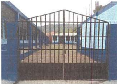
Foto 7: Fabricación e instalación de portón de metal de ingreso
