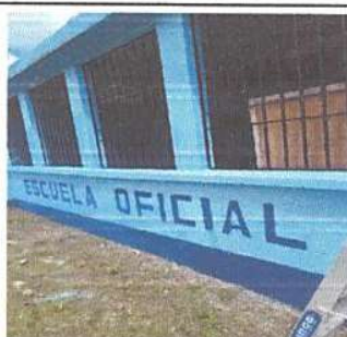
Foto 2: Mantenimiento a estructura de metal de ventana
