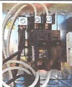
Foto 6: Reparación de cableado eléctrico
