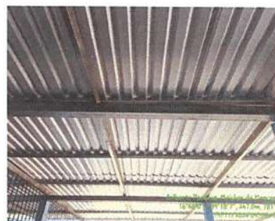
Foto 10: Desinstalación de estructura portante
