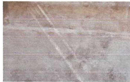
Foto 8: Repello en muro
