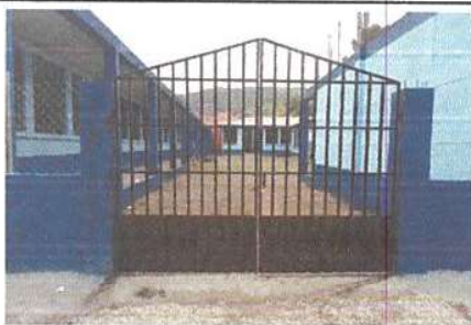
Foto 5: Reparación de muro perimetral de block.
