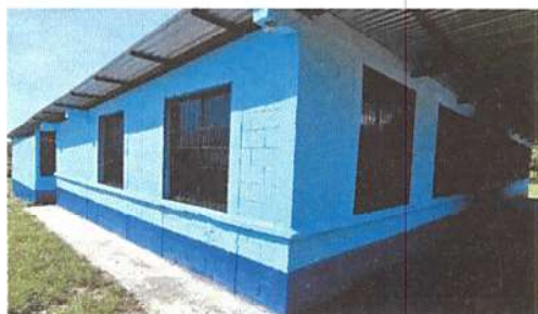
Foto 5: Pintura en muros exteriores e interiores
