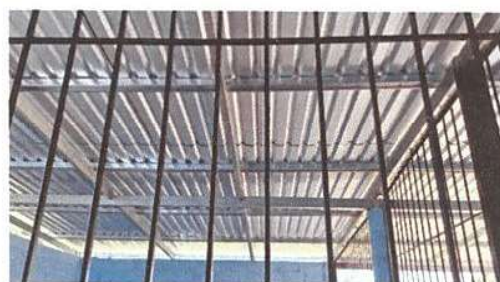
Foto 8: Instalación de estructura portante de metal
