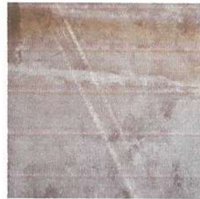
Foto 8: Repello en muro
