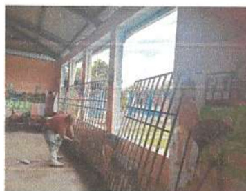
Foto 2: Mantenimiento a estructura de metal de ventana
