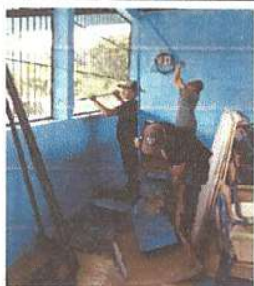
Foto 3: Pintura en muros exteriores e interiores
