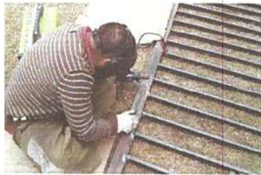
Foto 7: Fabricación e instalación de portón de metal de ingreso
