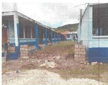
Foto 5: Reparación de muro perimetral de block.
