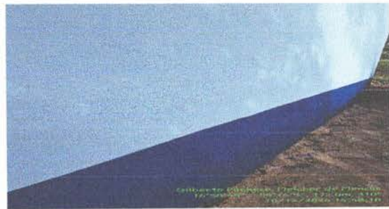
Foto 4: Pintura en muros exteriores e interiores
