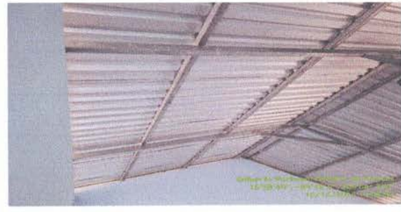
Foto 10: Instalación de lámina troquelada aluzinc
