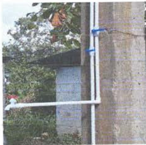
Foto 5: Sustrucción de tubería línea principal
