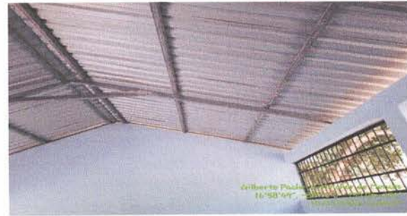
Foto 9: Instalación de estructura portante de metal
