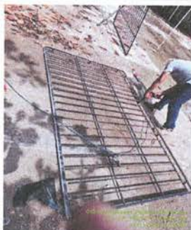
Foto 7: Fabricación e instalación de balcones de hierro en ventana
