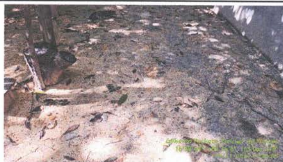
Foto 3: Sustrucción de piso de cemento liquido
