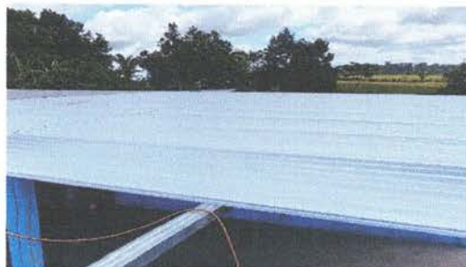
Foto 10: Instalación de lámina troquelada aluzinc
