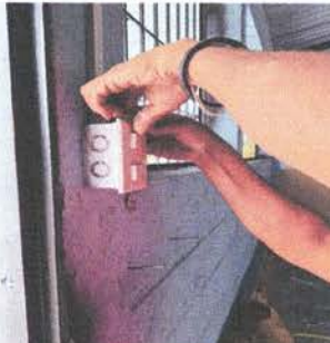
Foto 6: Sustrucción de ducto eléctrico + accesorios
