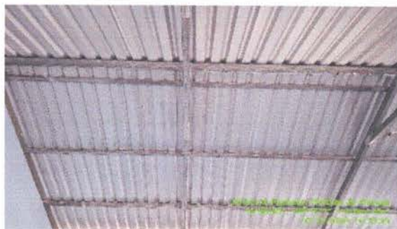
Foto 9: Instalación de estructura portante de metal
