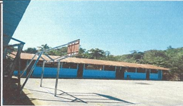
Foto 2 Renglon 1.1 Sustitución de lamina por lamina troquelada de calibre 26
