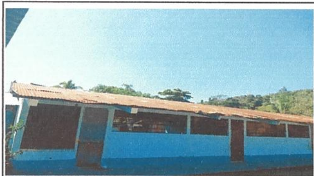
Foto 4 Renglon 4.3, sustitución de puertas en modulos
