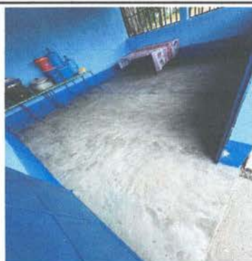
FOTO 9: Reparación de piso de cemento líquido.
