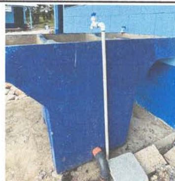
FOTO 8: Sustitución de tubería principal.
