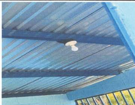
FOTO 7: Reparación del cableado eléctrico.
