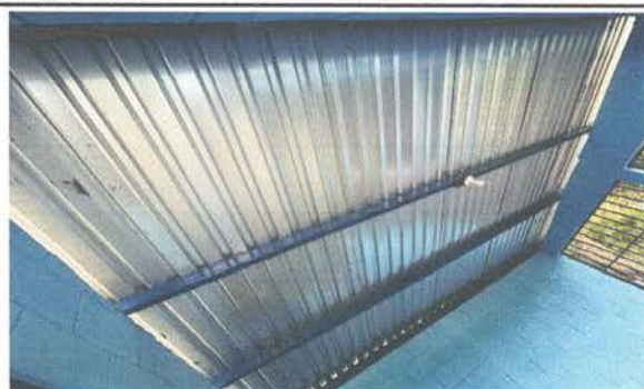
FOTO 10: Instalación de lámina troquelada Aluzinc.
