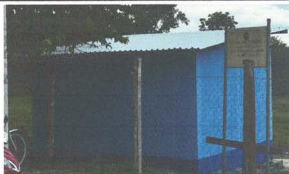
FOTO 6: Pintura en muros exteriores e interiores.
