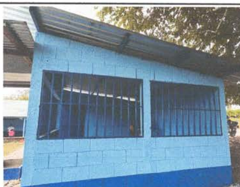
FOTO 4: Fabricación e intalacion de ventana-balcón de metal.
