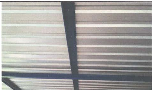
FOTO 3: Sustitución de elementos de fijación
