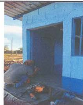
FOTO 6: Pintura en muros exteriores e interiores.
