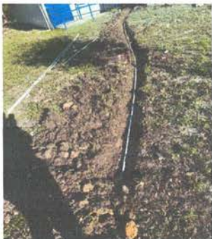
FOTO 8: Sustitución de tubería principal.
