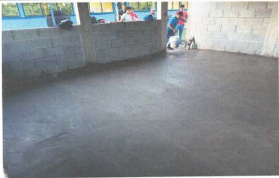
FOTO 9: Reparación de piso de cemento líquido.
