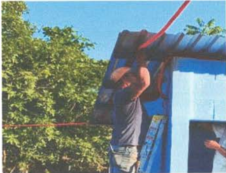
FOTO 7: Reparación del cableado eléctrico.
