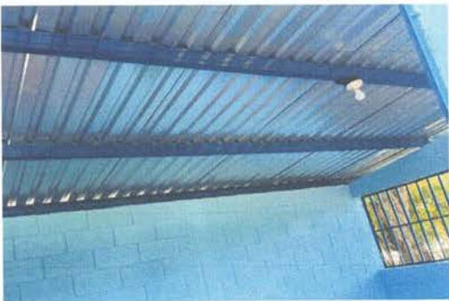
FOTO 10: Instalación de lámina troquelada Aluzinc.
