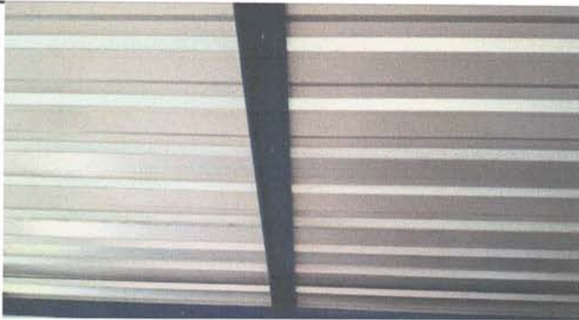
FOTO 3: Sustitución de elementos de fijación
