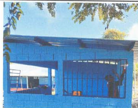
FOTO 4. Fabricación e intalacion de ventana-balcón de metal.
