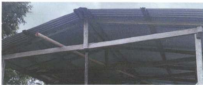
FOTO 3: Sustrución de capote de lámina para lámina troquelada.
