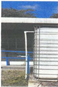
FOTO 9: Sustitución de tubería línea principal.
