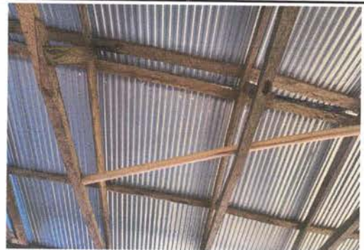
FOTO 2: Sustrución de estructura de soporte de madera por metal
