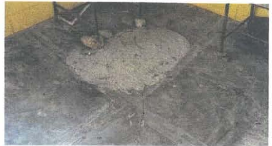
FOTO 10: Reparación de piso de cemento líquido.
