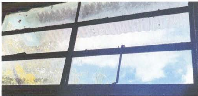
FOTO 5: Fabricación e instalación de ventana-balcón de metal.
