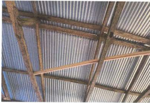
FOTO 1: Sustrución de lámina por lámina troquelada Aluzinc calibre 26
