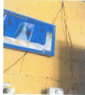
FOTO 8: Reparación de cableado eléctrico.
