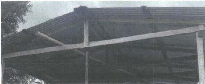
FOTO 11: Instalación de lámina troquelada Aluzinc
